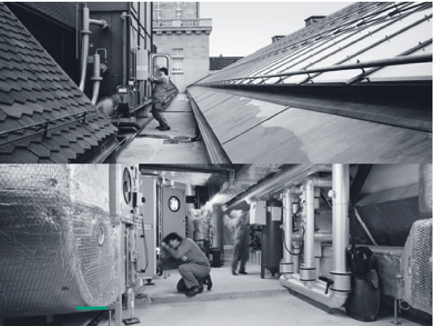
Universität Zürich Zentrum, Dachbereich
